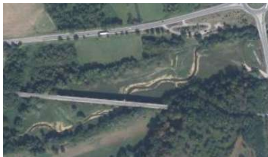
Vues aériennes (haut : 1950-65 et bas : période actuelle) de la zone ayant fait l'objet des travaux de réméandrement de la Vallière en 2022
