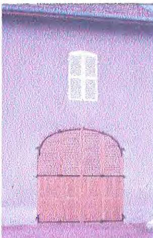
*La grange devient garage : le traitement de la porte, avec des portes pleines en partie basse, et des volets à persiennes en partie haute, permet de conserver l'image générale de la porte de grange tout en étant très fonctionnel.*
