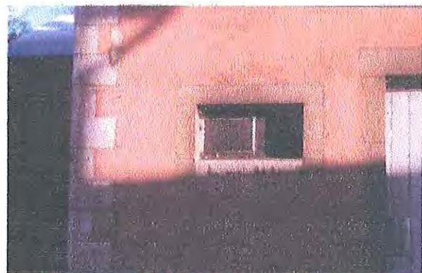
*Chaîne d'angle en trompe-l'oeil (badigeon) encadrement des ouvertures en pierres de taille taillées finement*
