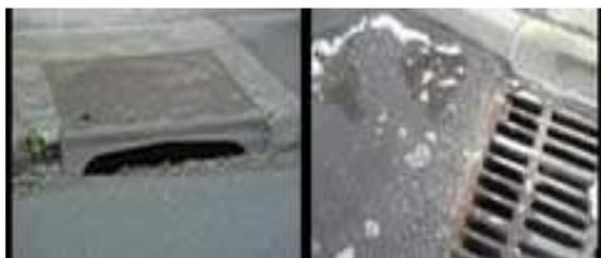
Les grilles pluviales et avaloirs ne sont pas raccordés au réseau d'eaux usées, mais à la rivière !
