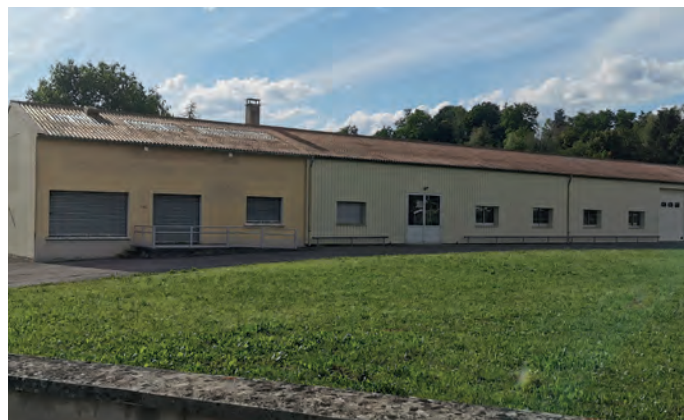
Le bâtiment qui accueillera bientôt le service communautaire de l'eau potable
