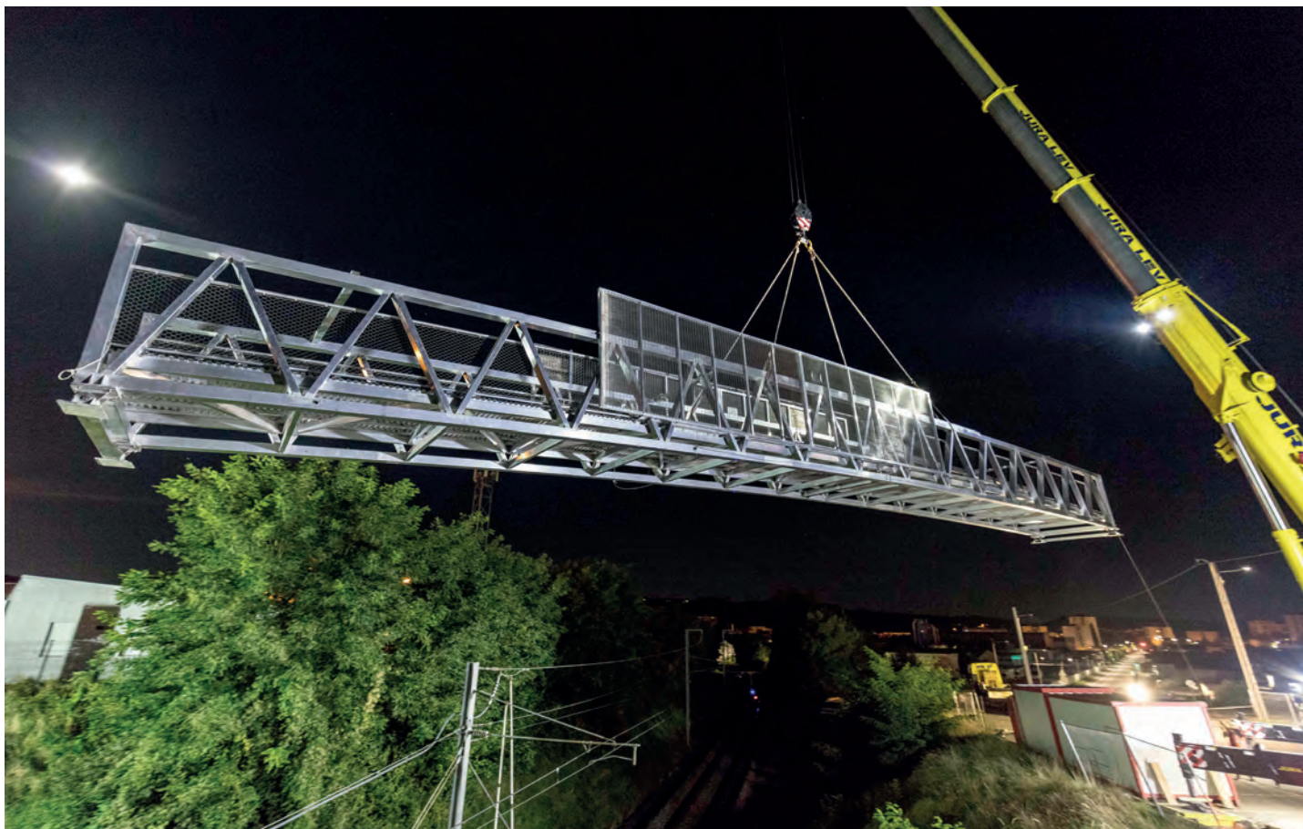
Mise en place de la passerelle de Perrigny durant la nuit du 13 au 14 septembre.
