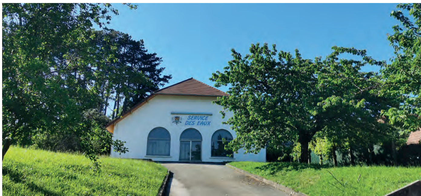
Installation rue du château d'eau à Lons-le-Saunier
